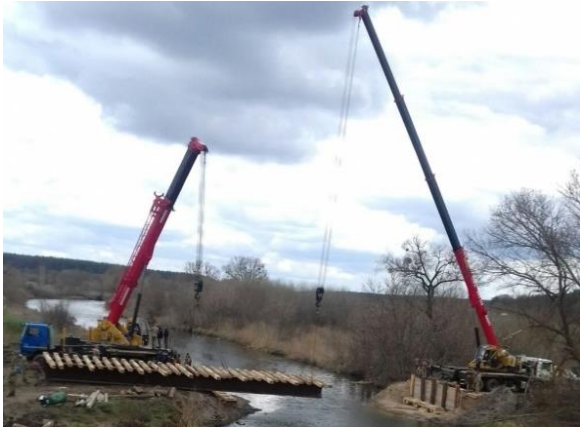
Рис. 8. Монтаж прогонових будов
